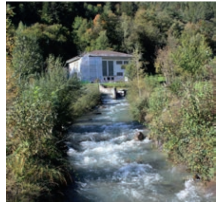
Das renaturierte Auslauferinne mit dem Kraftwerk «Bocki» im Hintergrund.
