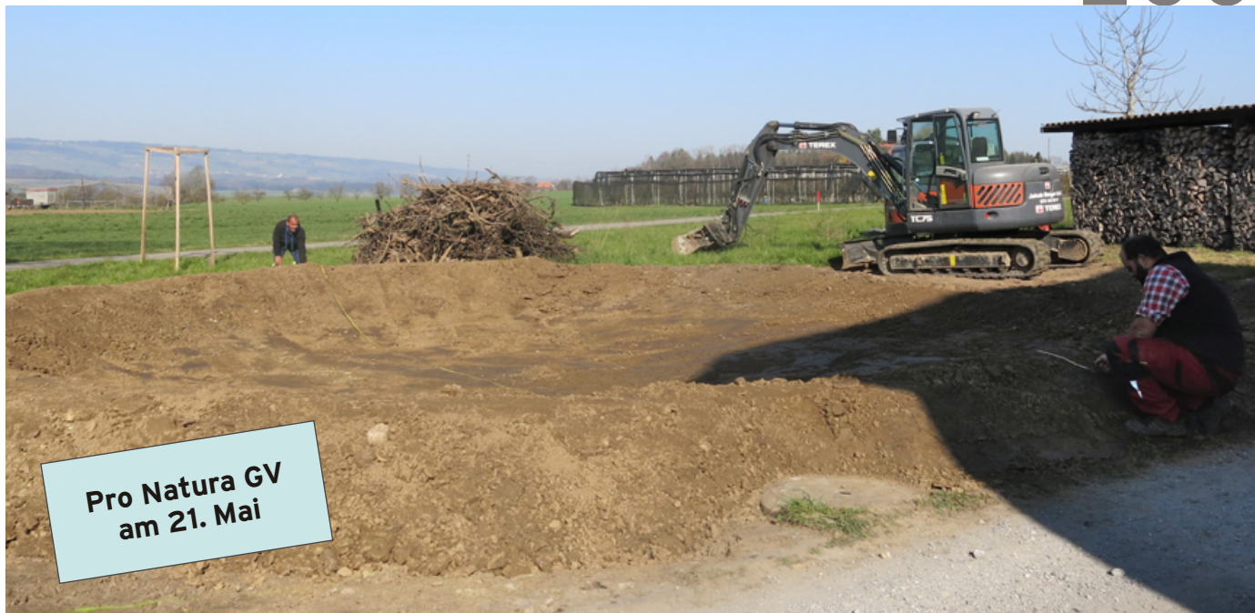
Noch fehlt das Wasser. Die im März erfolgten Aushubarbeiten deuten aber an, wo der Teich zu liegen kommt. Die Mulde wird nun mit einer Teichfolie abgedichtet, mit Kies überschüttet und der Randbereich schliesslich mit Sträuchern und Strukturelementen ergänzt. (Foto: Marianne Rutishauser)
