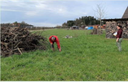
Markieren der Teichlage vor dem Bau mit dem Unternehmer. (Foto: Ursula Herzog)
