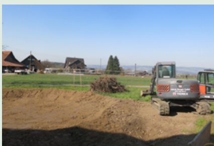
Für den Aushub des Teichs kommen auch grosse Baumaschinen zum Einsatz. (Foto: Marianne Rutishauser)
