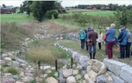
Da der Mittelbach bei Hochwasser viel Material mit sich führt, wurde im Übergang zur Ebene ein Kiessammler mit Holzrechen erstellt.
