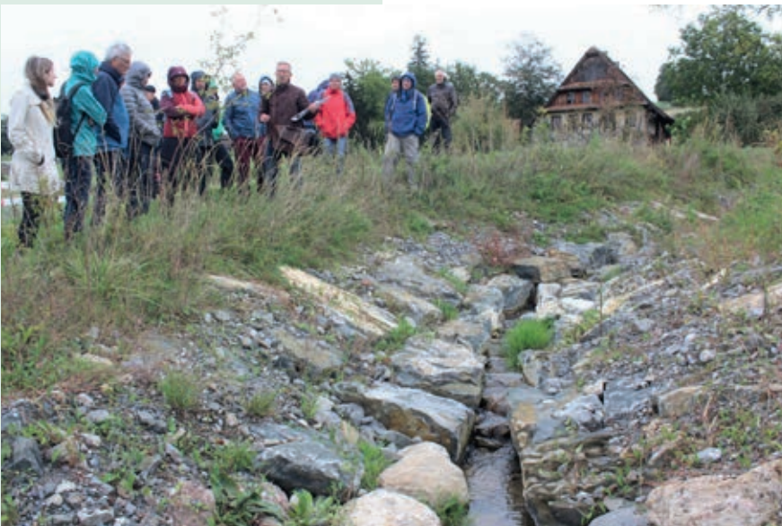
Die Sohle des Margelbachs wirkt stark verbaut. Die Blocksteine wurden jedoch bewusst so gesetzt, um für Steinkrebse Unterschlupfmöglichkeiten zu bieten.
