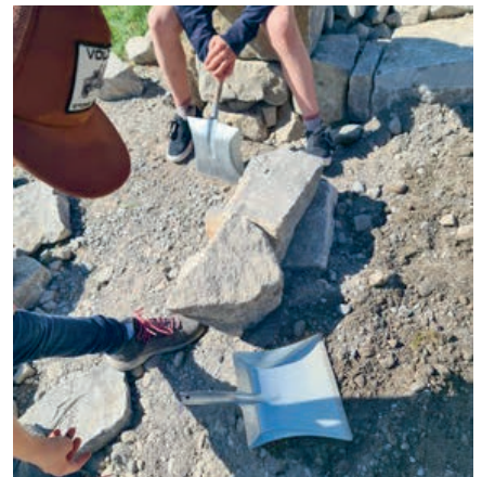
Trockenmauerbau. (Foto: Naturerlebnis Zug)
